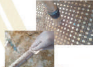
Dépoussiérage et décapage
